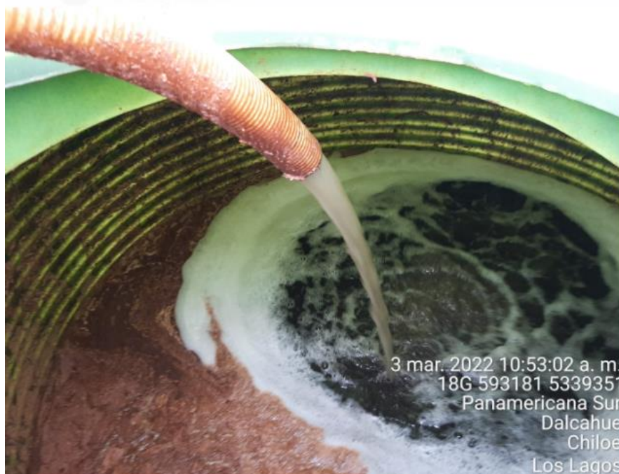
Fotografía N°13: Retiro de Lixiviados a estanque por personal municipal. Tomada: Jueves 03 de Marzo del 2022.
