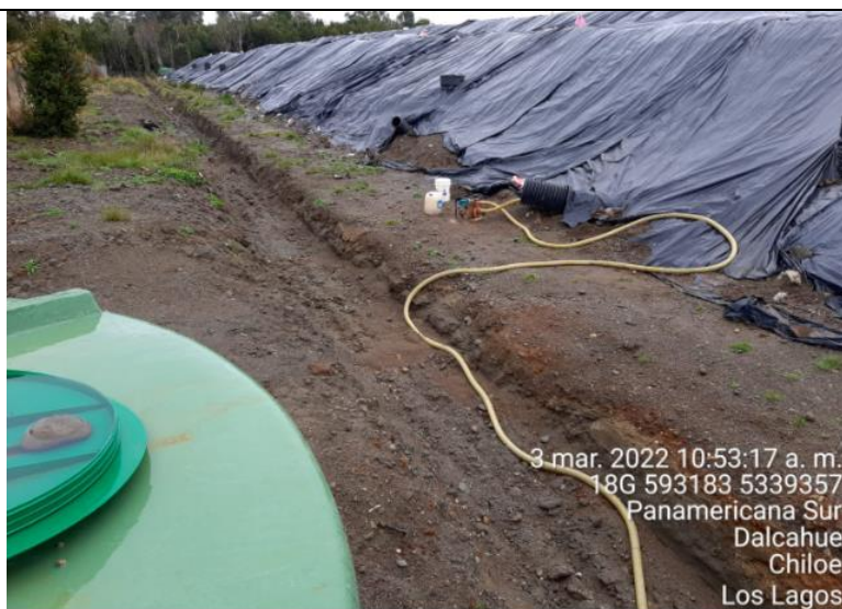
Fotografía N°12: Retiro de Lixiviados desde diagonal D02. Tomada: Jueves 03 de Marzo del 2022.
